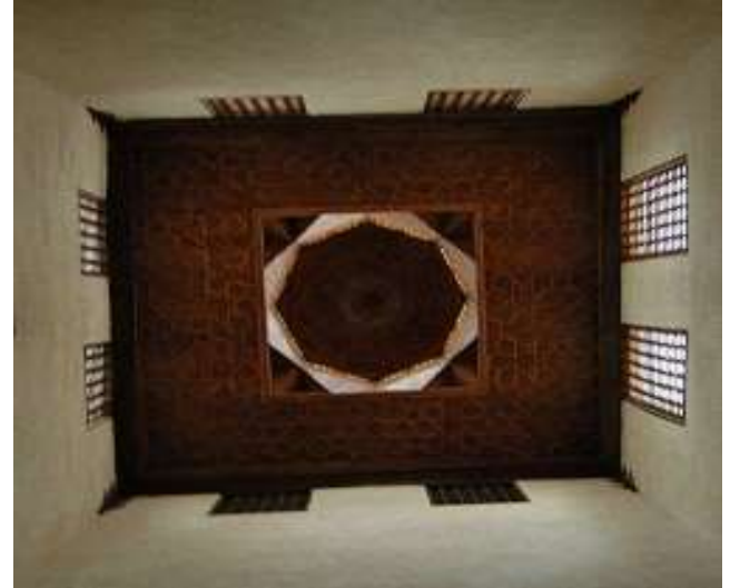
الشكل (١٤) استخدام الخشب في الأسقف (الشخشيخة)
