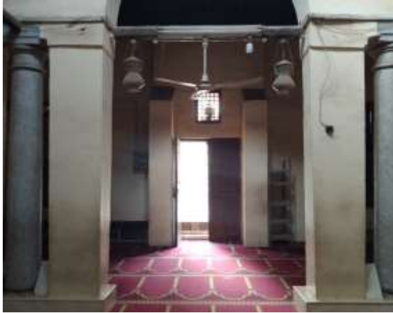
(لوحة 8) الدعامات البارزة التي تكتنف المدخل من الداخل
