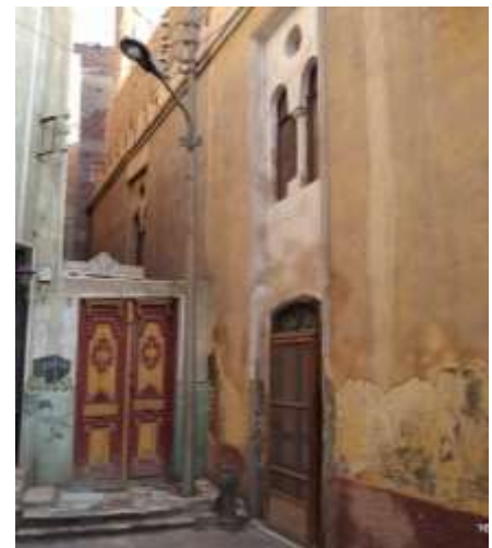
( لوحة 19 ) الواجهة الشمالية الشرقية والمدخل الفرعي
