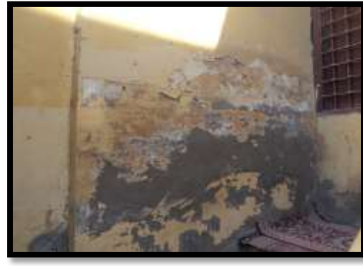
صورة رقم (3) توضح تأثير المياه الأرضية على الحوائط الحاملة للبلاطات الخزفية
