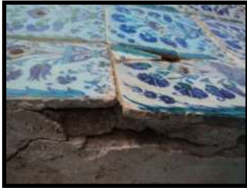
صورة رقم (9) توضح تطبل و تساقط المونة الرابطة بين البلاطات الخزفية مما يجعلها علي وشك السقوط
