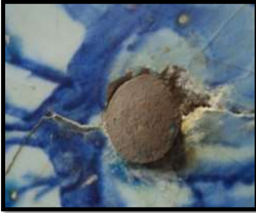
صورة رقم (19) توضح تساقط أجزاء من سطح البلاطات وضعفها حول المسامير الحديدي
