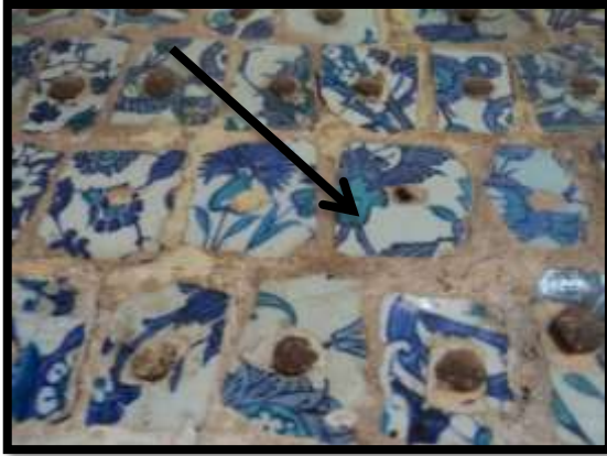
صورة رقم (17) توضح طريقة رص قطع من البلاطات صغيرة غير منتظمة الاشكال ورص بدون تنسيق وفوقها مونة مما يؤدي الى اختفاء الملامح لها
