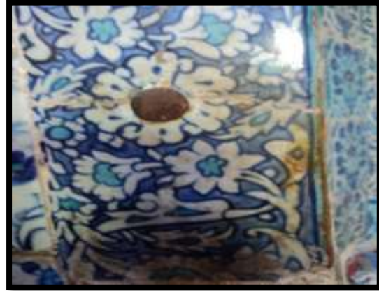
صورة رقم (18) توضح تأثير المسامير على البلاطات حيث أدت إلى تشقق وشروخ فى البلاطة
