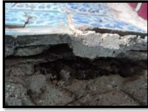
صورة رقم (8) توضح انفصال البلاطات عن الحامل نتيجة لتبلور الأملاح
