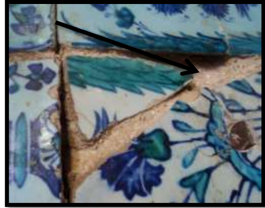
صورة رقم (16) توضح طريقة تجميع كسر من البلاطات بطريقة عشوائية وغير مرتبة
