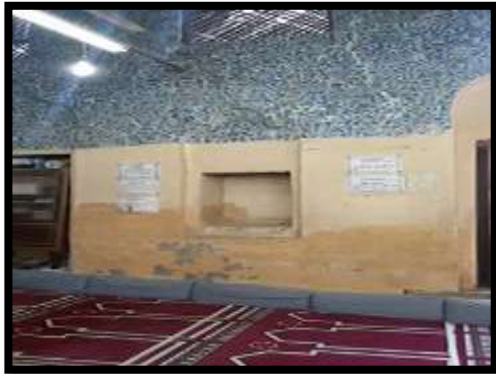
صورة رقم (4) توضح مظاهر تلف المياه الأرضية وتأثيرها على الجدران الحاملة للبلاطات الخزفية
