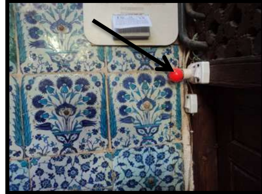
صورة رقم (10) توضح أحد مصادر الحرارة الناتجة عن الإضاءة من المصابيح وهي تؤثر بطريقة مباشرة على البلاطات
