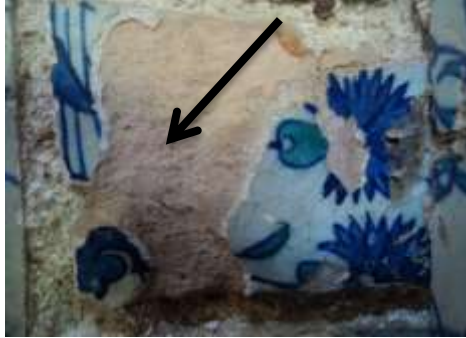
صورة رقم (7) توضح تساقط طبقات التزجيج السطحية نتيجة لتبلور الأملاح
