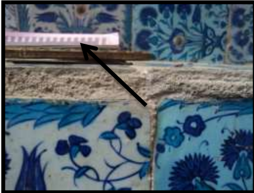
صورة رقم (15) توضح التلف البشرى المتمثل في استخدام وتعليق بعض الأدوات لاستذكارها
