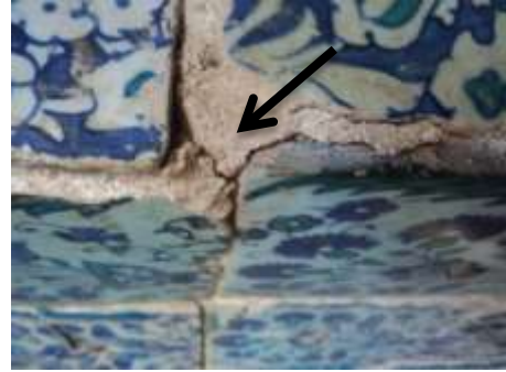
صورة رقم (6) توضح تأثير الأملاح على طبقة التزجيج السطحية و تساقطها
