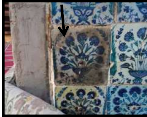
صورة رقم 5 توضح الشروخ في طبقة التزجيج السطحية في بعض البلاطات
