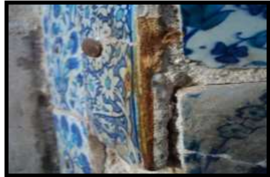
صورة رقم (20) توضح الصدأ نتيجة المسامير و تسربقع الصدأ على جانب البلاطات
